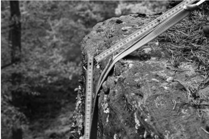
Der rechts oben sichtbare Ankerstich wird bei Belastung wegen Dehnung der Schlingen auf den rauhen Sandstein im Bereich des Felsrandes gepresst Foto: O. Fuchs
